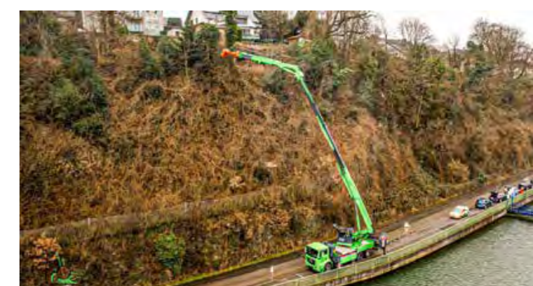
Arbeiten ohne Sperre beider Fahrstreifen möglich.
