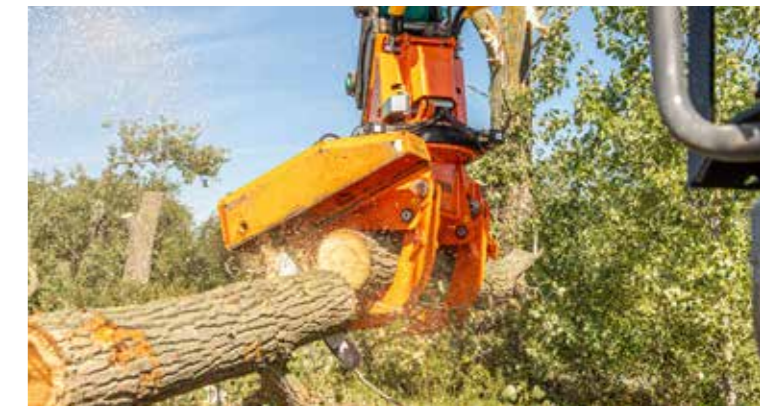
Tronçonnage en fagot et dépose rapide.
