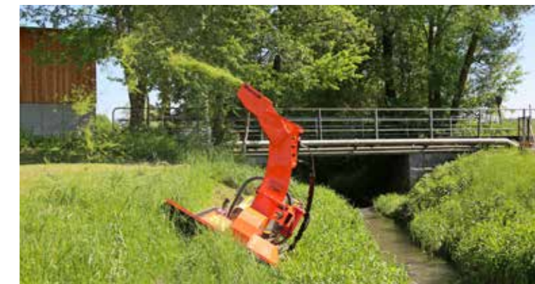
Pour des endroits inaccessibles pour la débroussailluse.
