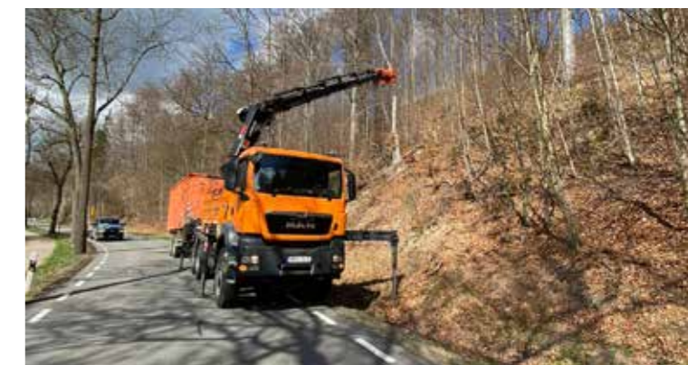
Travail possible sans fermer les deux voies de circulation.
