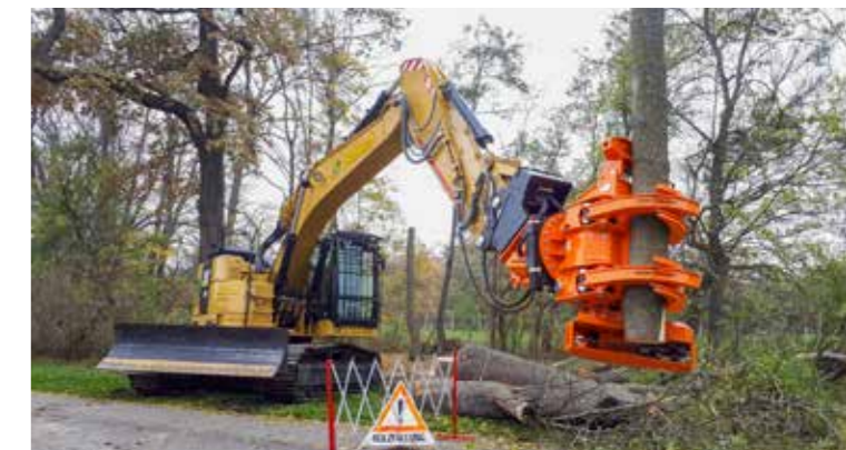
Démontage des arbres en morceaux.
