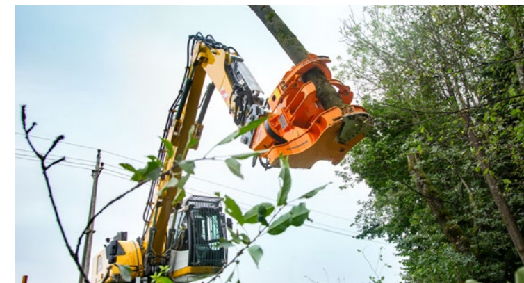
Manutenzione delle reti.
